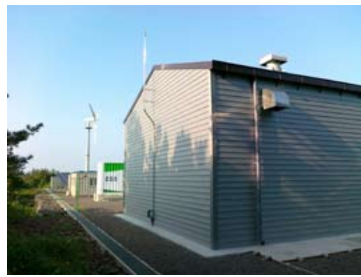
100kW, 200kWh, 韩国能源研究院智能电网项目, 韩国济州岛
