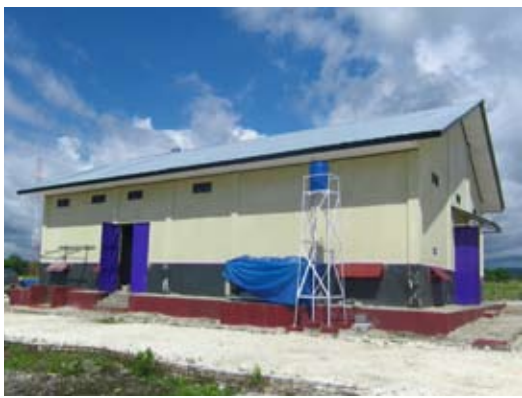
400kW, 500kWh, 岛屿微电网应用, 印尼松巴岛
