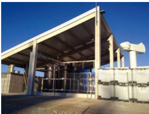
50kW, 200kWh, CENER微网研究项目, 西班牙纳瓦拉省
