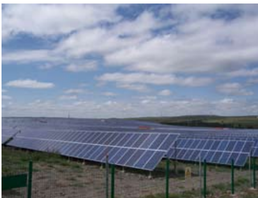
2MW, 8MWh, 国家风光储输电示范项目一期工程, 中国张北
